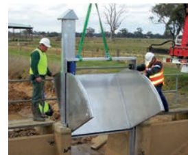
Instal·lació en sec
